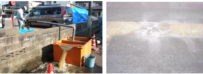
図-9 揚砂状況（左）とノズルからの揚砂（右）
