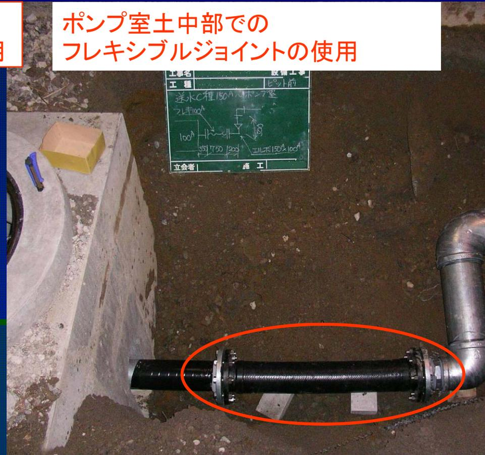
ポンプ室と土中部の配管の不等沈下対策や振動対策として使用
